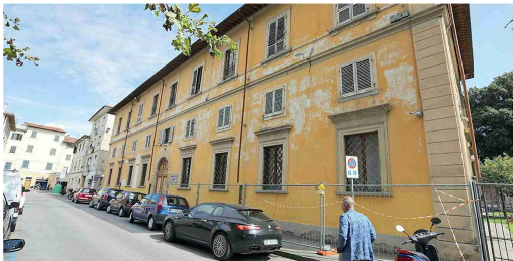
In alto il palazzo in via 24 Luglio trasformato in condominio solidale Freedom e sede della Casa della Salute Gino Strada
